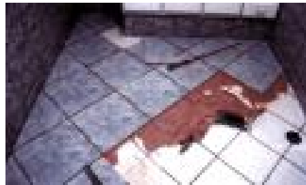
DEPLACAMENTO OCORIDO EM FUNÇÃO DA ALTA EXPANSÃO POR UMIDADE E JUNTAS INADEQUADAS
